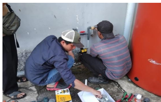
Gambar 3. Pemasangan panel surya sebagai sumber energi distribusi air
