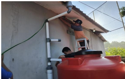
Gambar 1. Pemasangan instalasi penampungan air hujan
